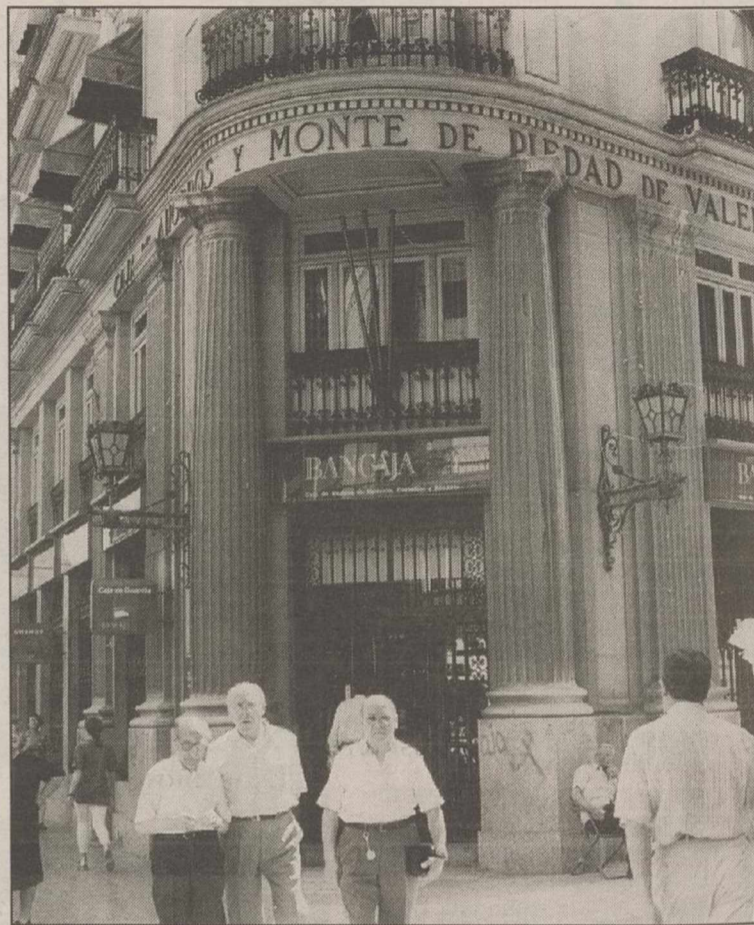
El edificio de la calle Ancha tiene más protección que el viejo Ayuntamiento.
