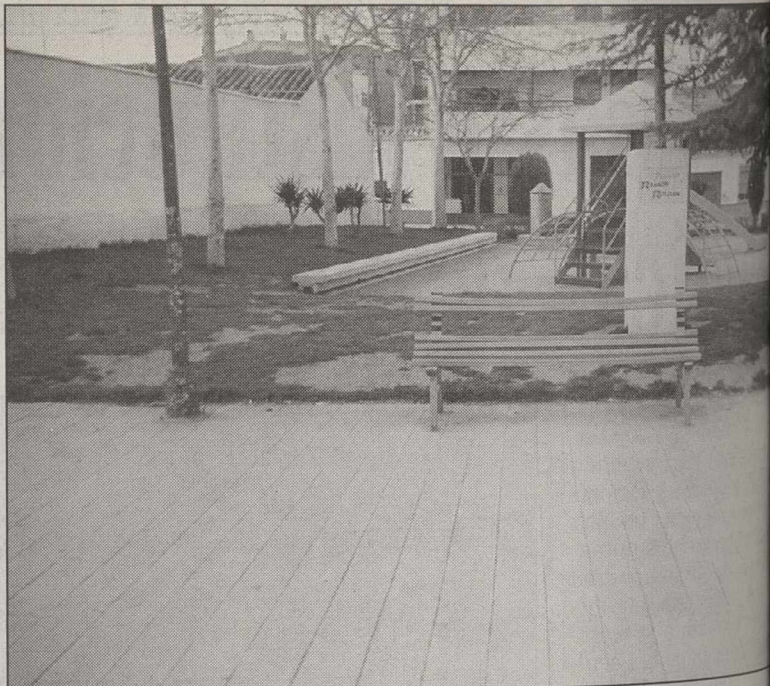
Deficiencias en mobiliario y césped de una zona a cargo de Fomento de Construcciones y
