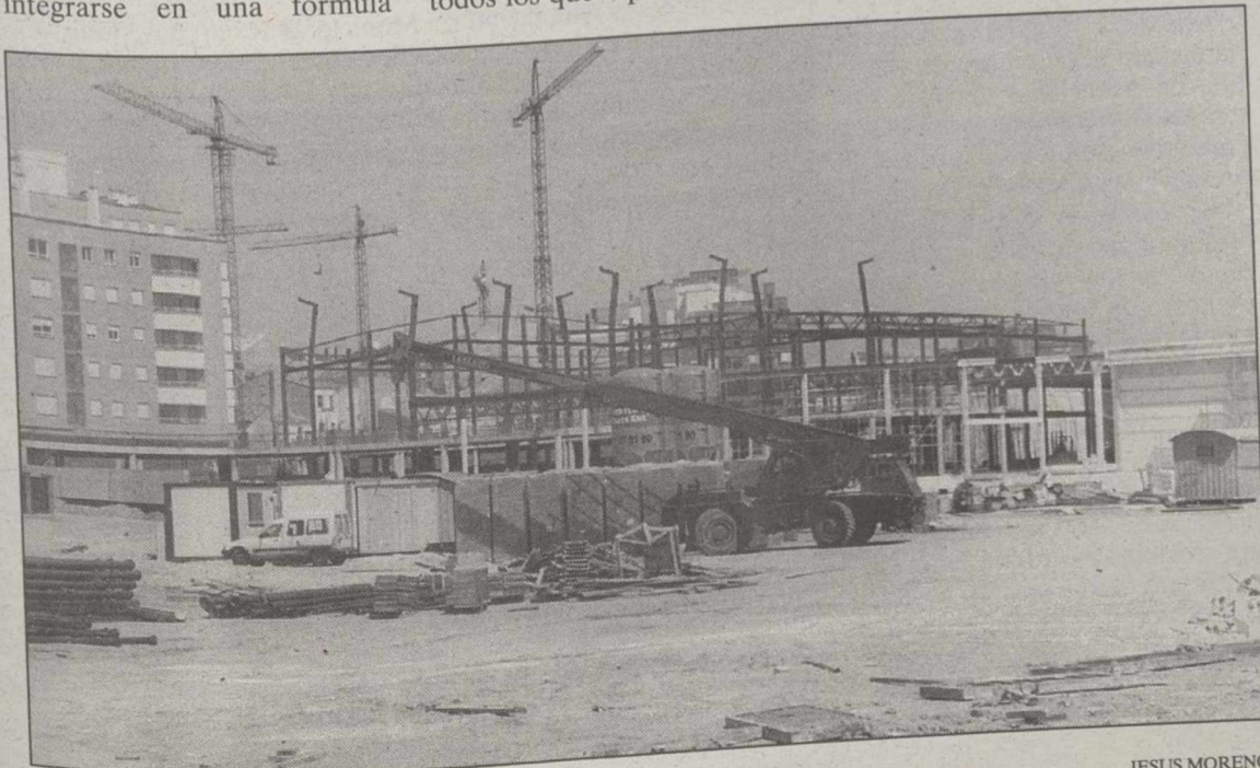
Estado actual de las obras del gran centro comercial situado en Alcalde Conangla.
