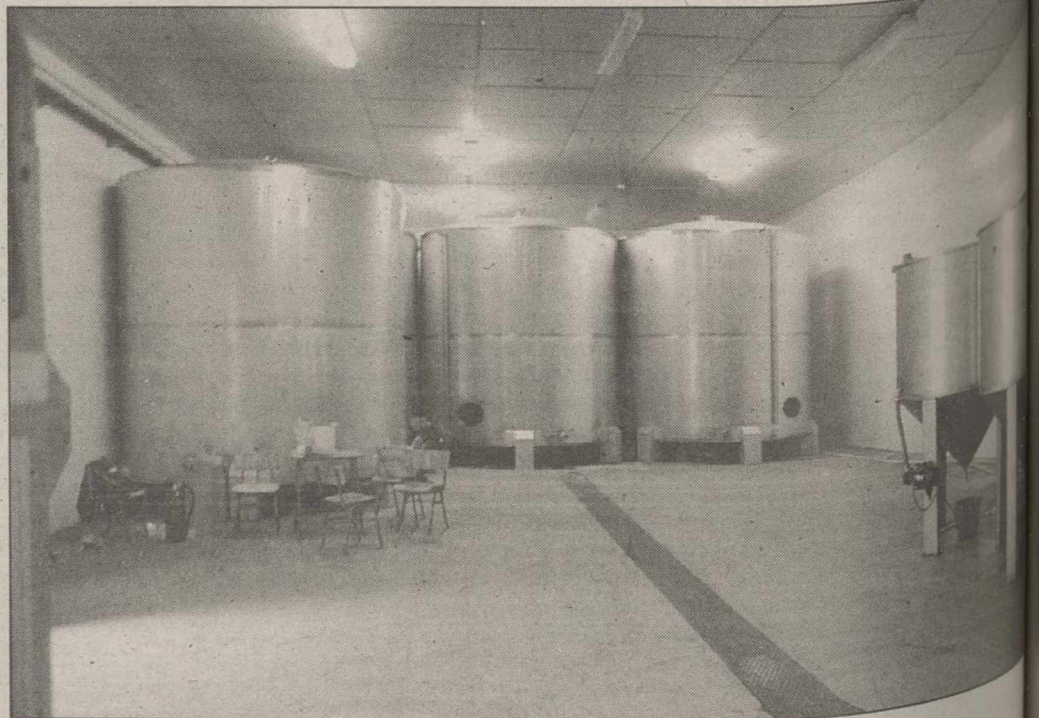
Depósitos de almacenamiento de aceite en la Cooperativa "La Serrana".
