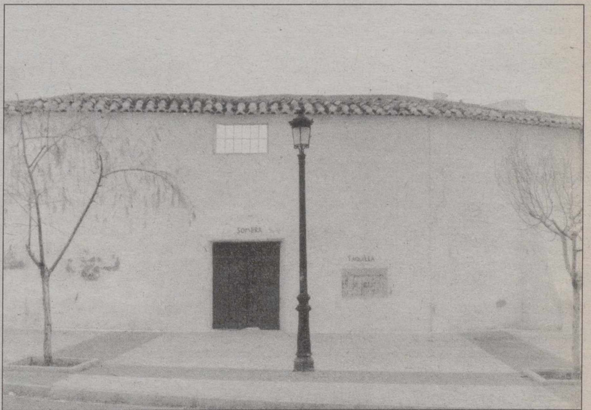
La Casa de Oficios se encarga de las tareas de restauración de la plaza de toros de Tobarra.
