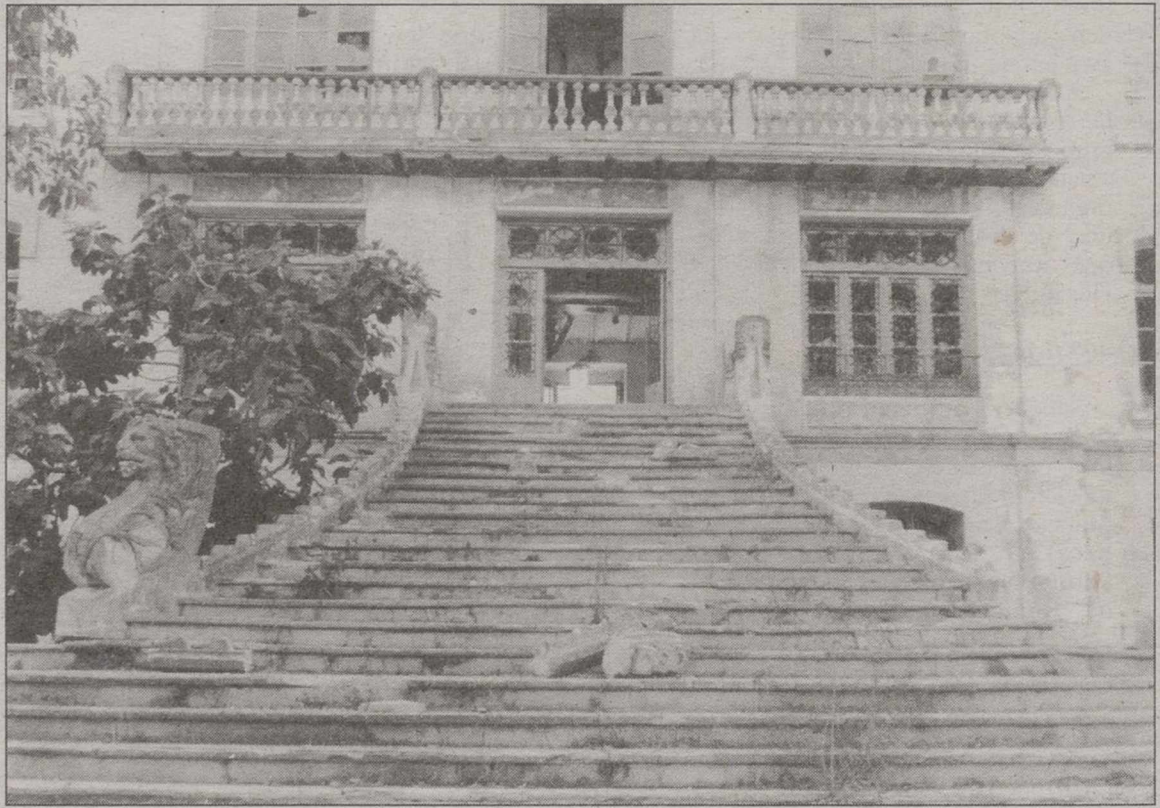
IU achaca parte del deterioro del edificio a la dejadez del Ayuntamiento.
