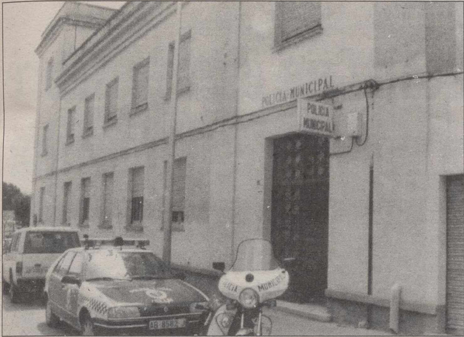
Cuando finalicen las obras la Policía Local se cambiará a sus nuevas dependencias.
