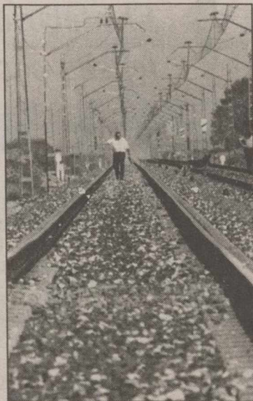
Inspección de la vía férrea.
