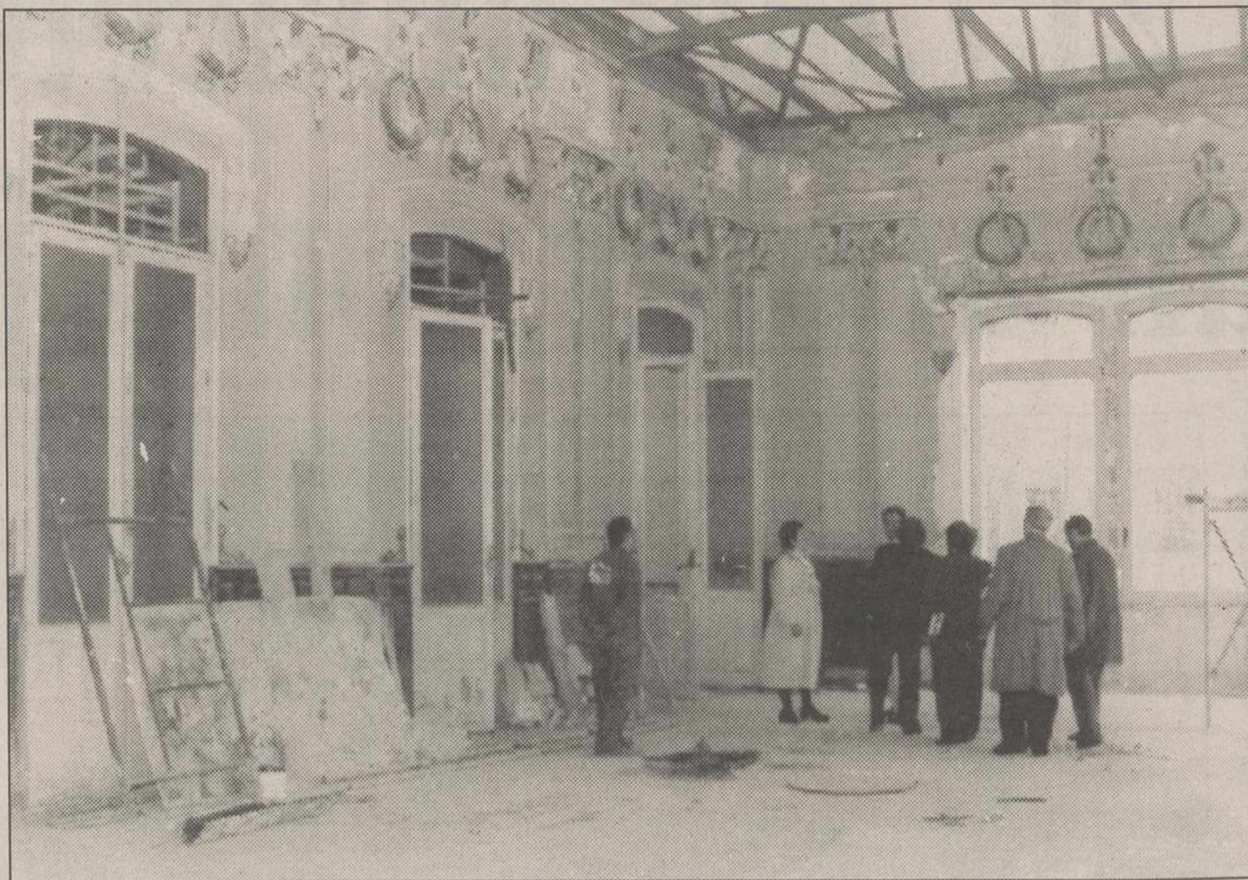
Las obras de rehabilitación del interior se realizarán en un plazo de siete meses.
