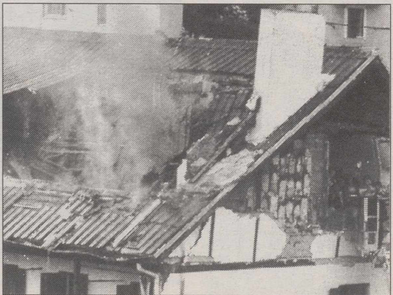
Aspecto de la casa tras la explosión registrada ayer en San Sebastián.
