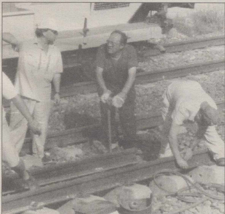
Los operarios trabajaron para restablecer el tráfico. A la derecha un trozo de vía.
