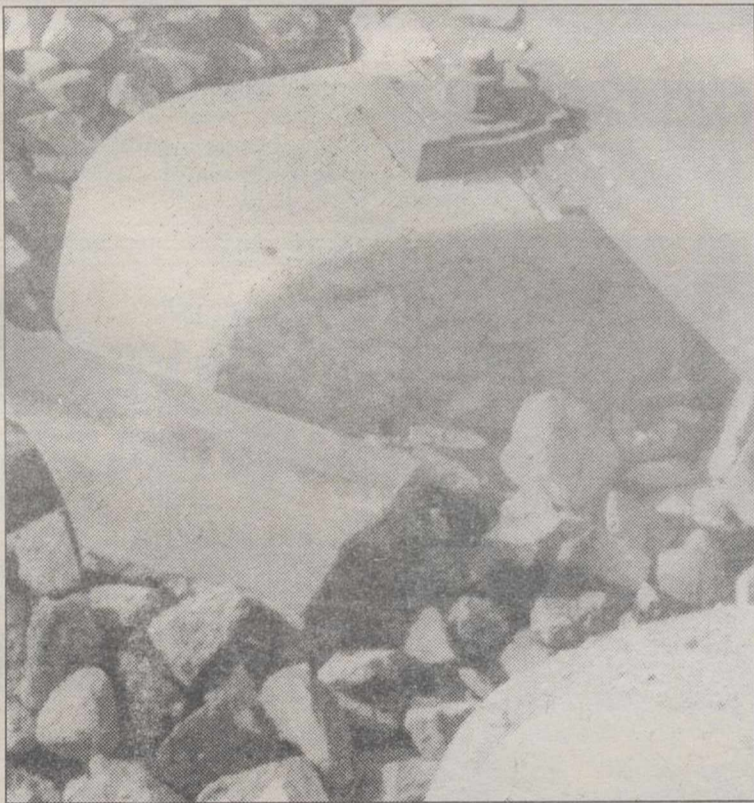
Uno de los trozos de vía que fueron despedidos por la onda expansiva.
