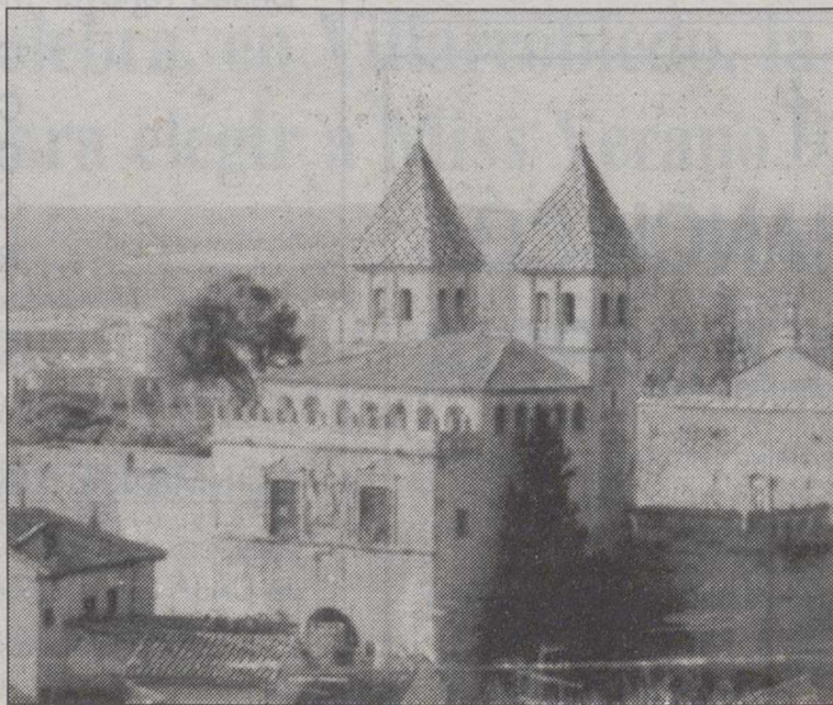
Toledo tendrá dos nuevas depuradoras.
