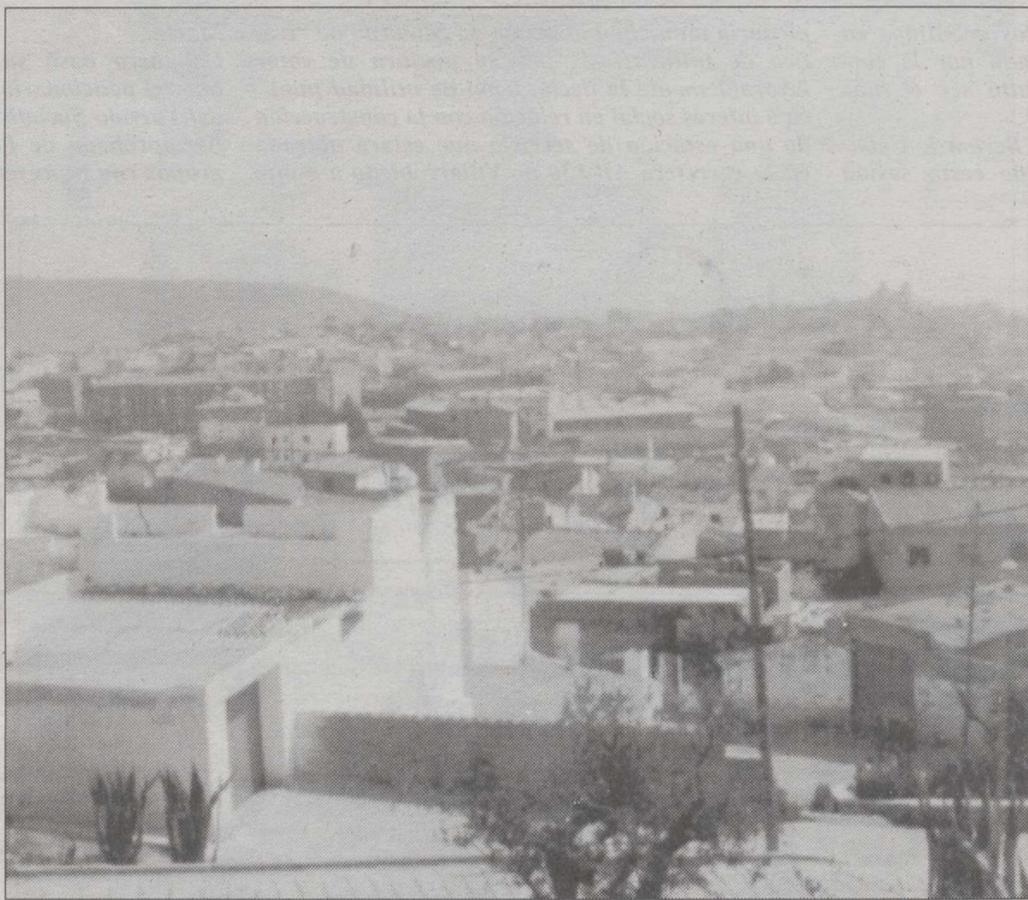
El colector de aguas pluviales es una obra vital para evitar inundaciones.
