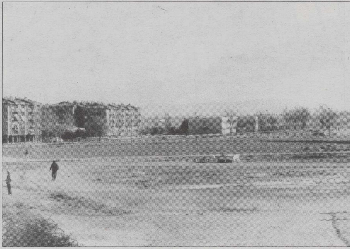
El proyecto para construir un gran centro comercial en el sector 1 sigue avanzando.
