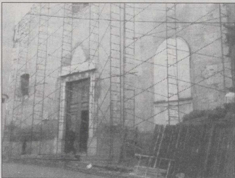
Las obras acabarán en el mes de mayo.
