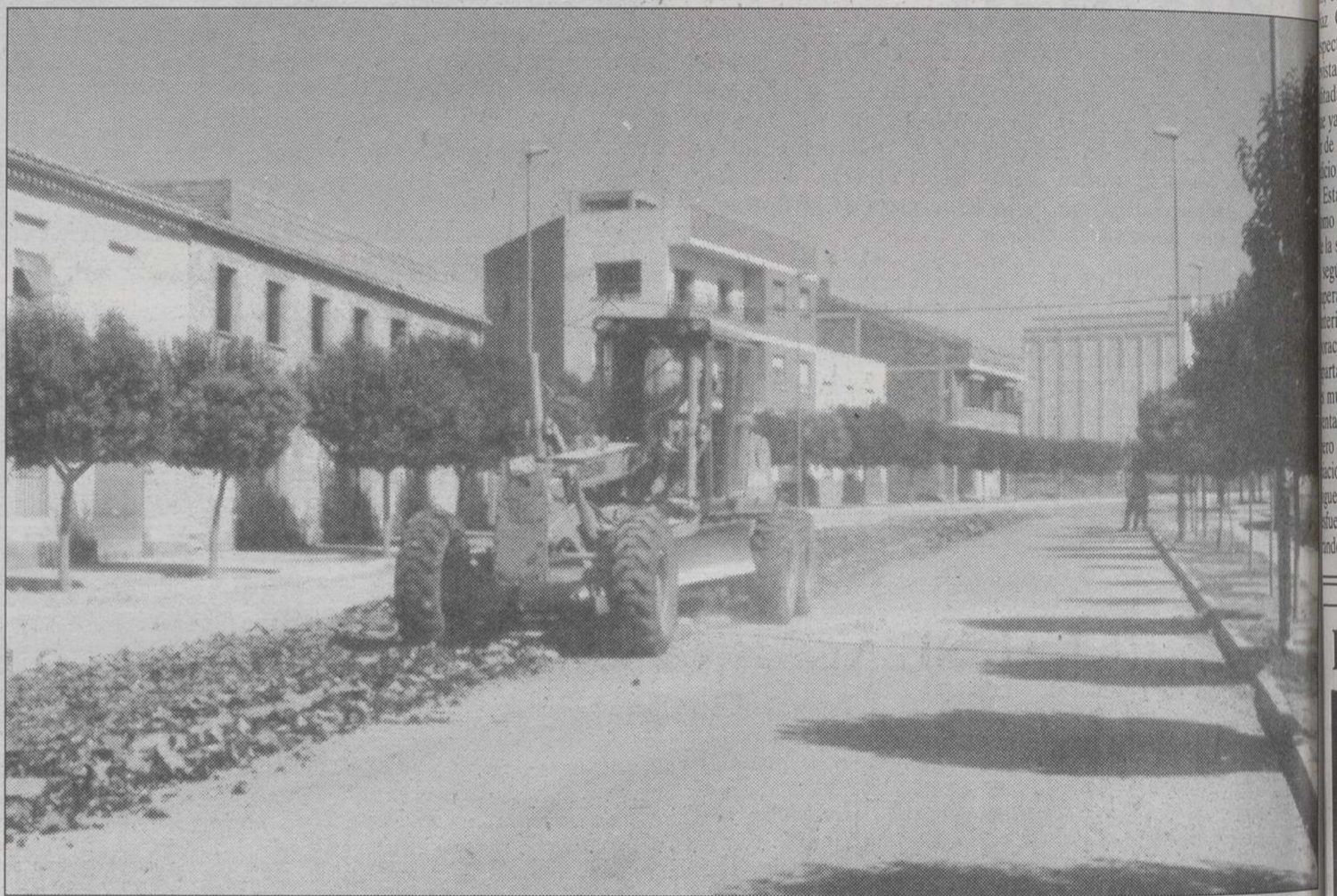
Se llevará a debate el pago del asfaltado de la Avda. de la Constitución.
