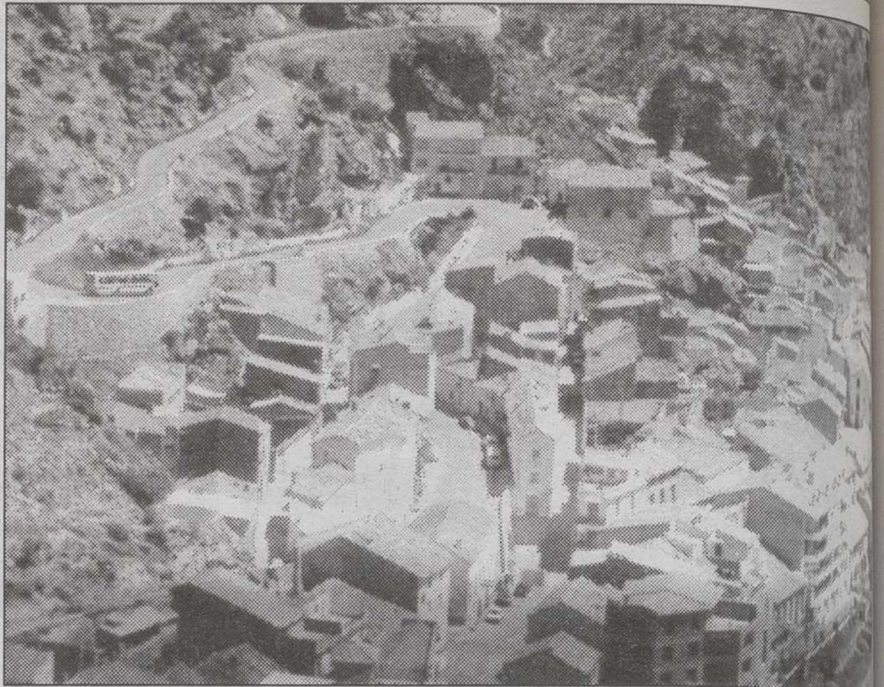
Se ha construido un cercado enfrente del pueblo.
