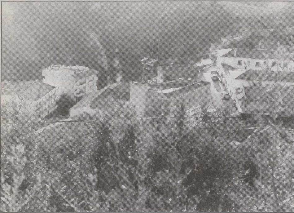
Se han consolidado rocas con peligro de desprendimiento.
