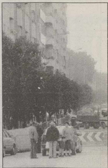
Obras en pleno centro.
