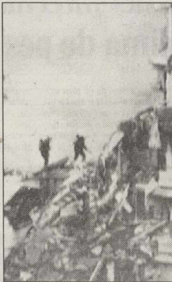
Prosigue las labores de rescate.
