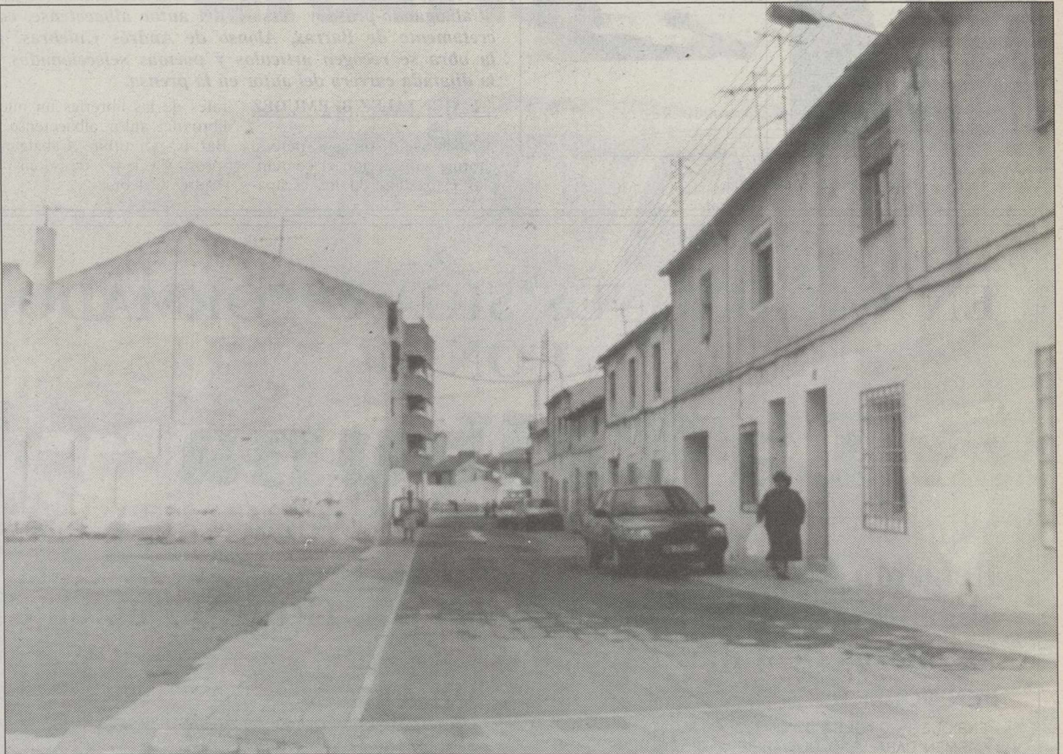
“Hay una segunda intención en las permutas del Ayuntamiento, por solares de Carretas”.
