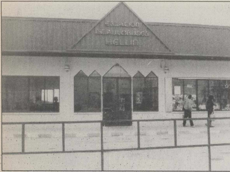
Deficiencias en la Estación de Autobuses.
