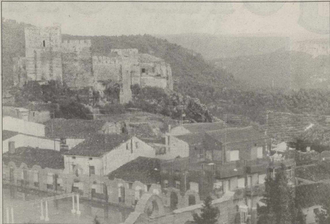
Las obras de abastecimiento en Yeste "amortizarán la inversión en el ahorro energético y mejorarán la calidad".
