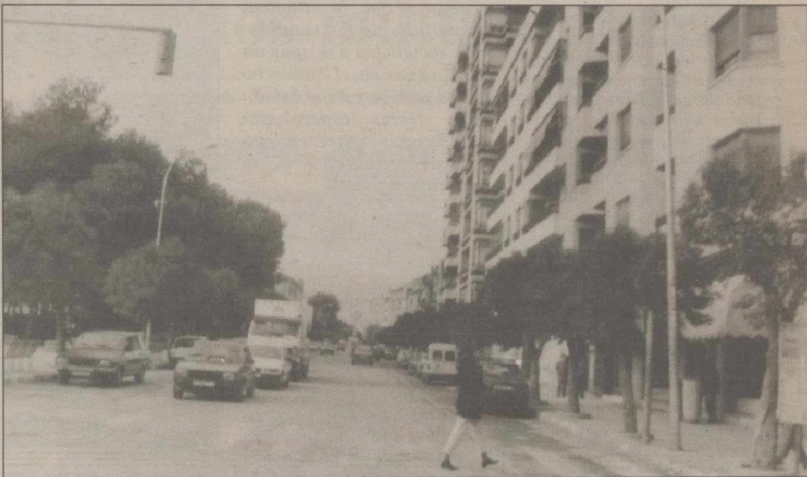
Problemas para la circulación por las obras en la Gran Vía.
