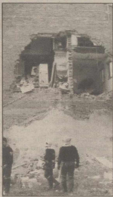
Aspecto del edificio dañado.
