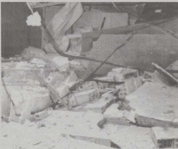
La nave quedó totalmente destruida tras la explosión.
