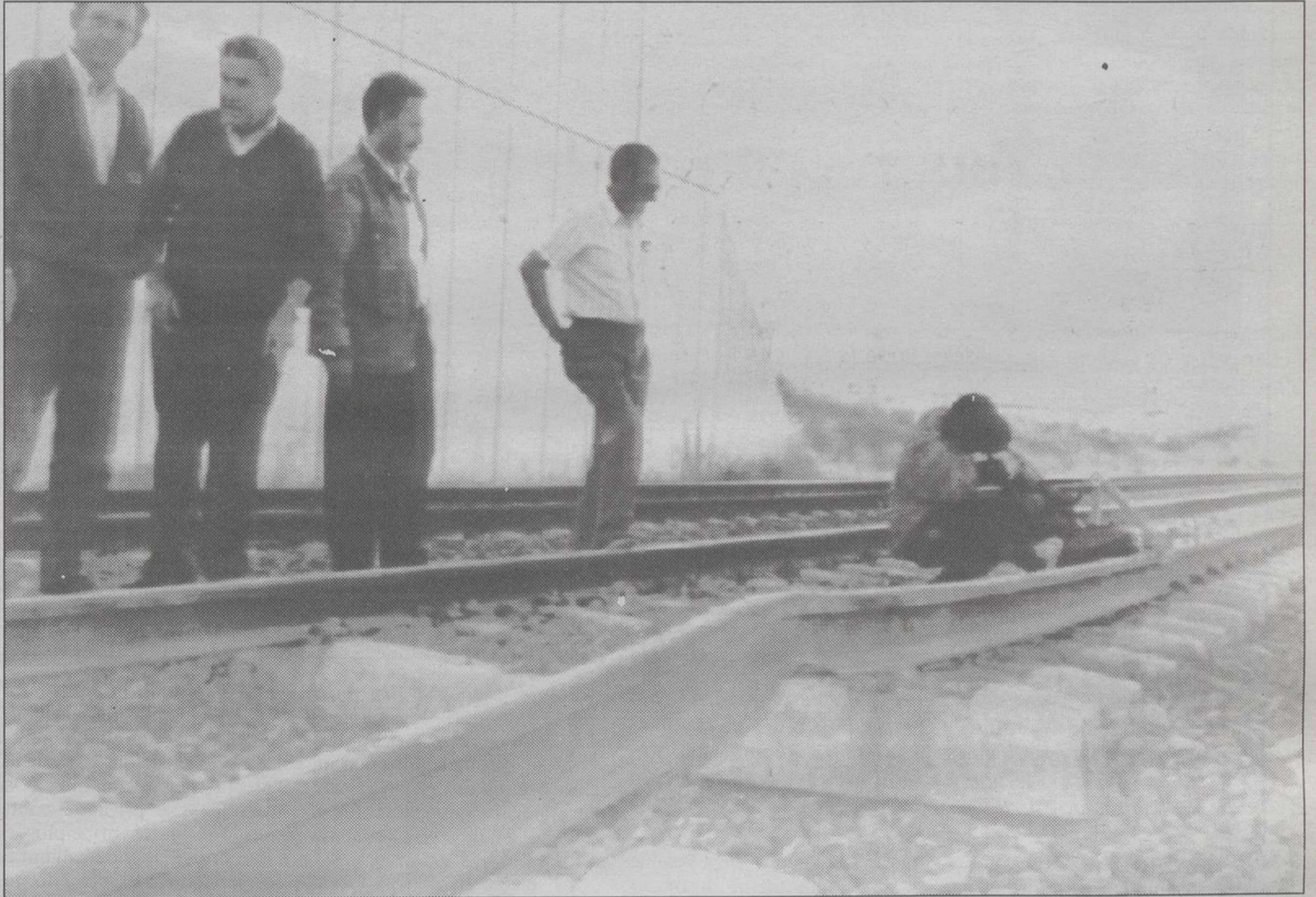
El estallido en Villamurriel del Cerrato, causado por una carga de 1,5 kilos de explosivo, levantó 130 metros de vía.
