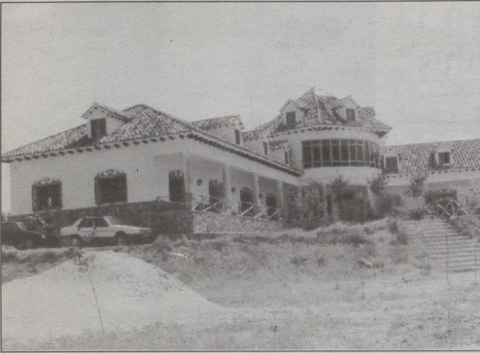
Vista de la "casita", típica construcción rústica.
