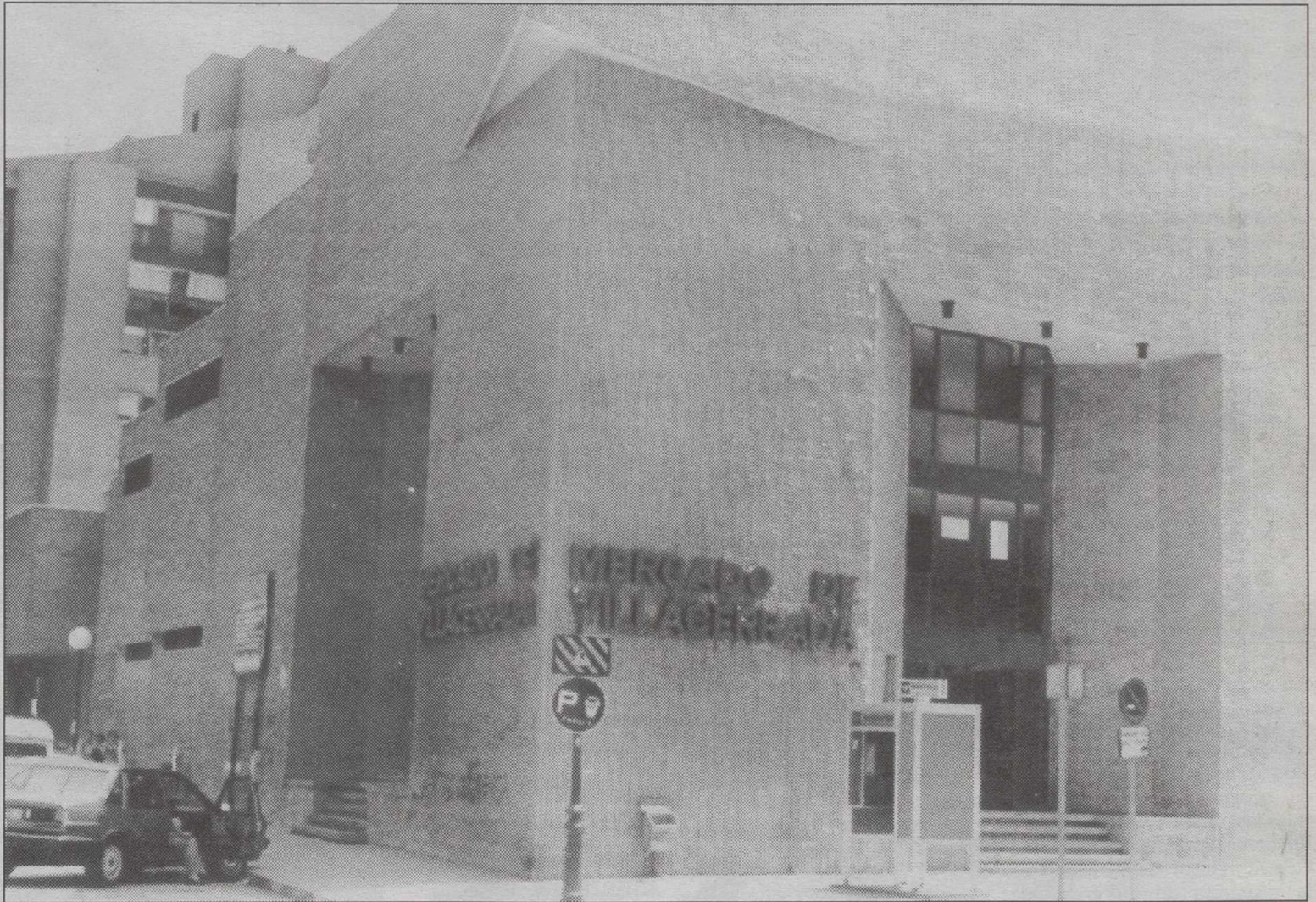
Las obras de reforma del Mercado de Villacerrada ya nacieron con polémica, por la falta de un acuerdo tácito entre usuarios y Ayuntamiento.
