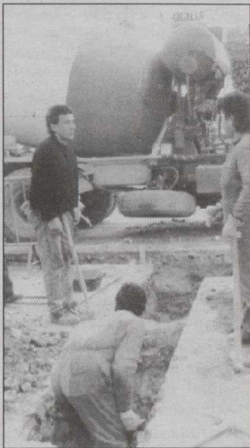
Obras de canalización.
