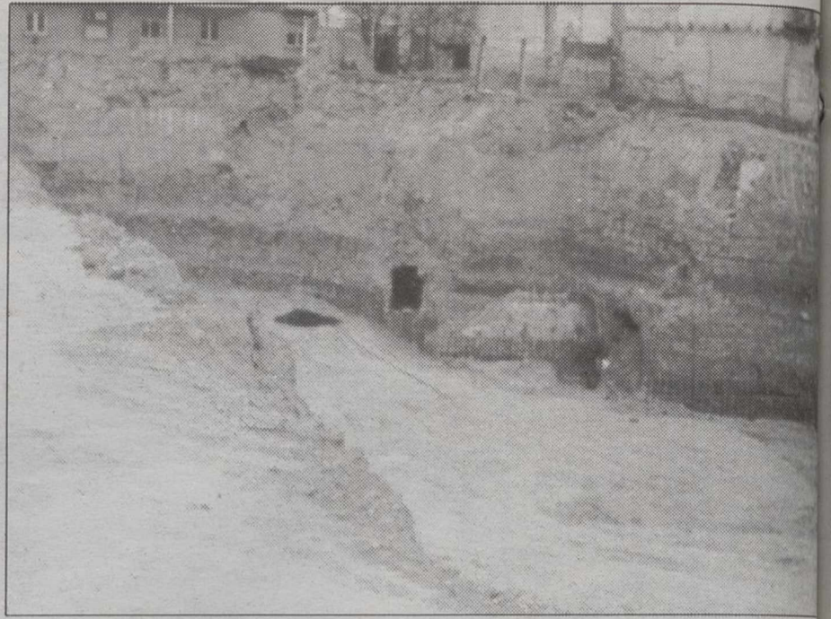
Vista de las excavaciones realizadas para la construcción del aparcamiento subterráneo.
