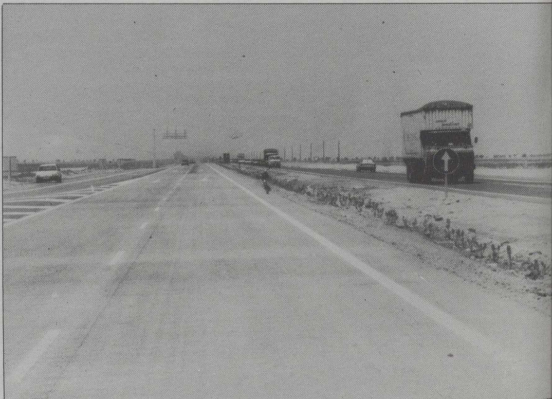
Una vista de la Autovía de Levante, momentos antes de que fuera inaugurado este tramo.
