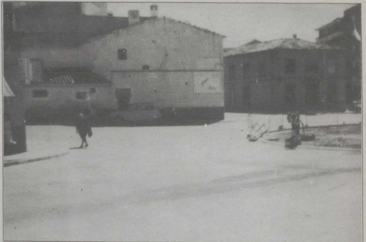
Otro aspecto de las obras
