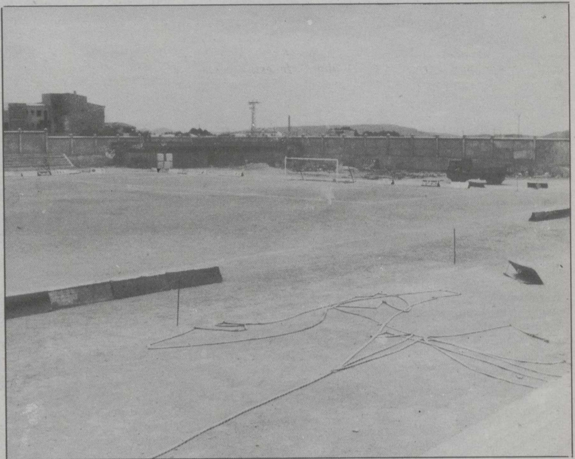
El Polideportivo, en obras.
