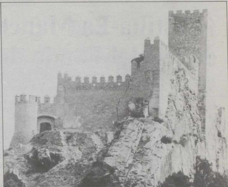
Las obras evitarán la ruina del castillo.
