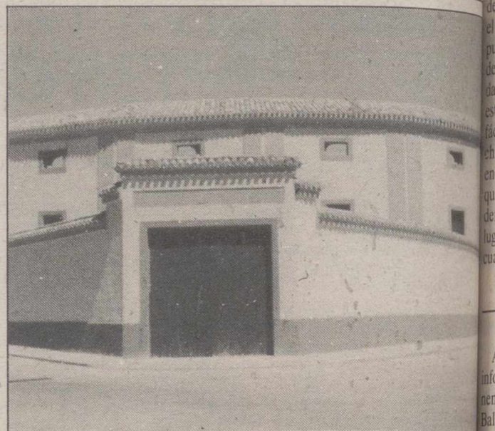
La Plaza de Toros, a falta de la culminación de obras
