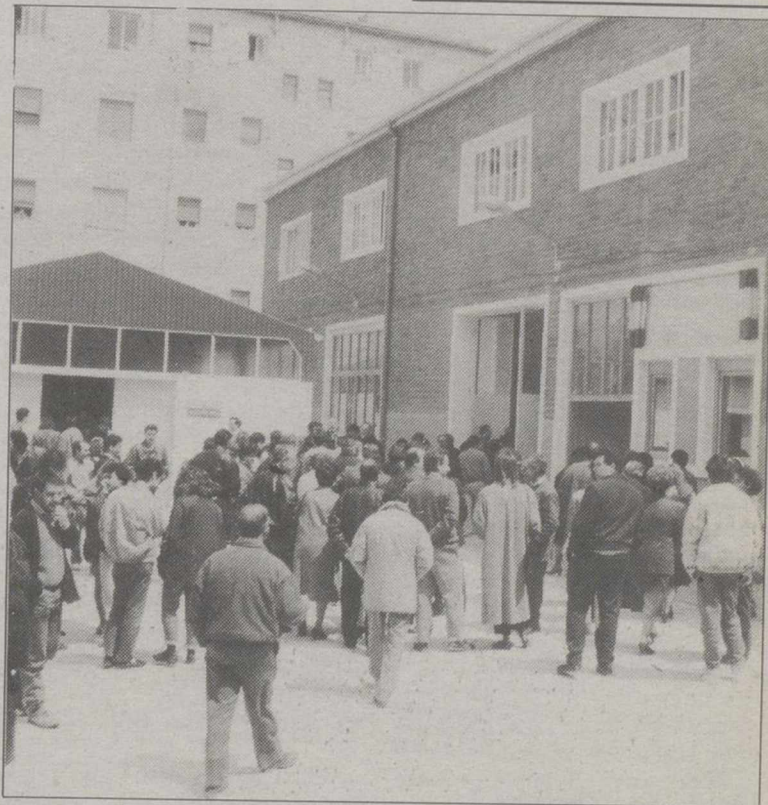
La sede se ubica en las naves de la antigua industria de la madera.
