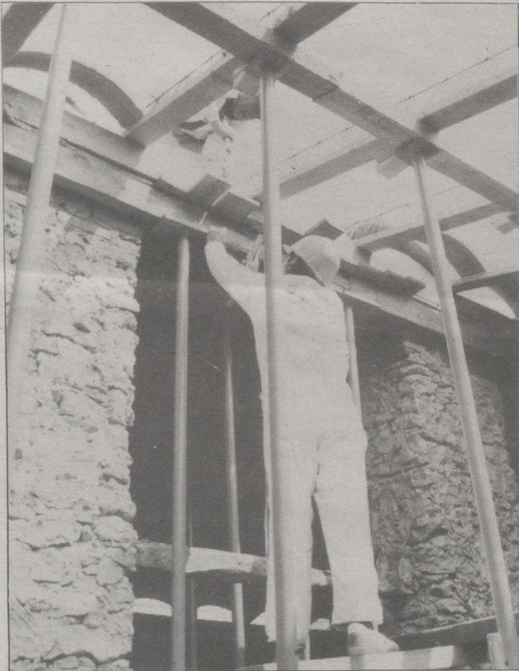
Rehabilitación de la casa del Barrio de S. Roque.
