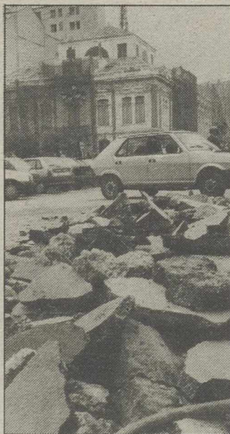
Terminan las obras.
