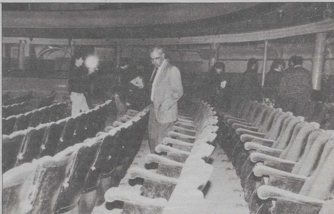
El alcalde de Albacete revisó el estado de conservación del patio de butacas de la planta baja del Teatro Circo
