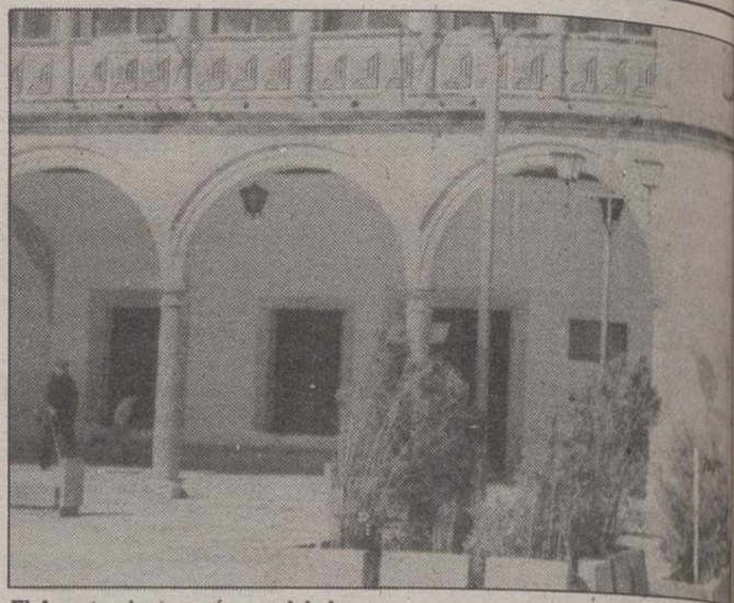
El Ayuntamiento será remodelado.
