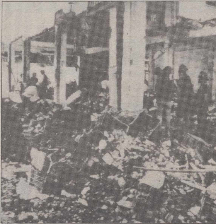
Estado en que quedó el edificio tras la explosión.
