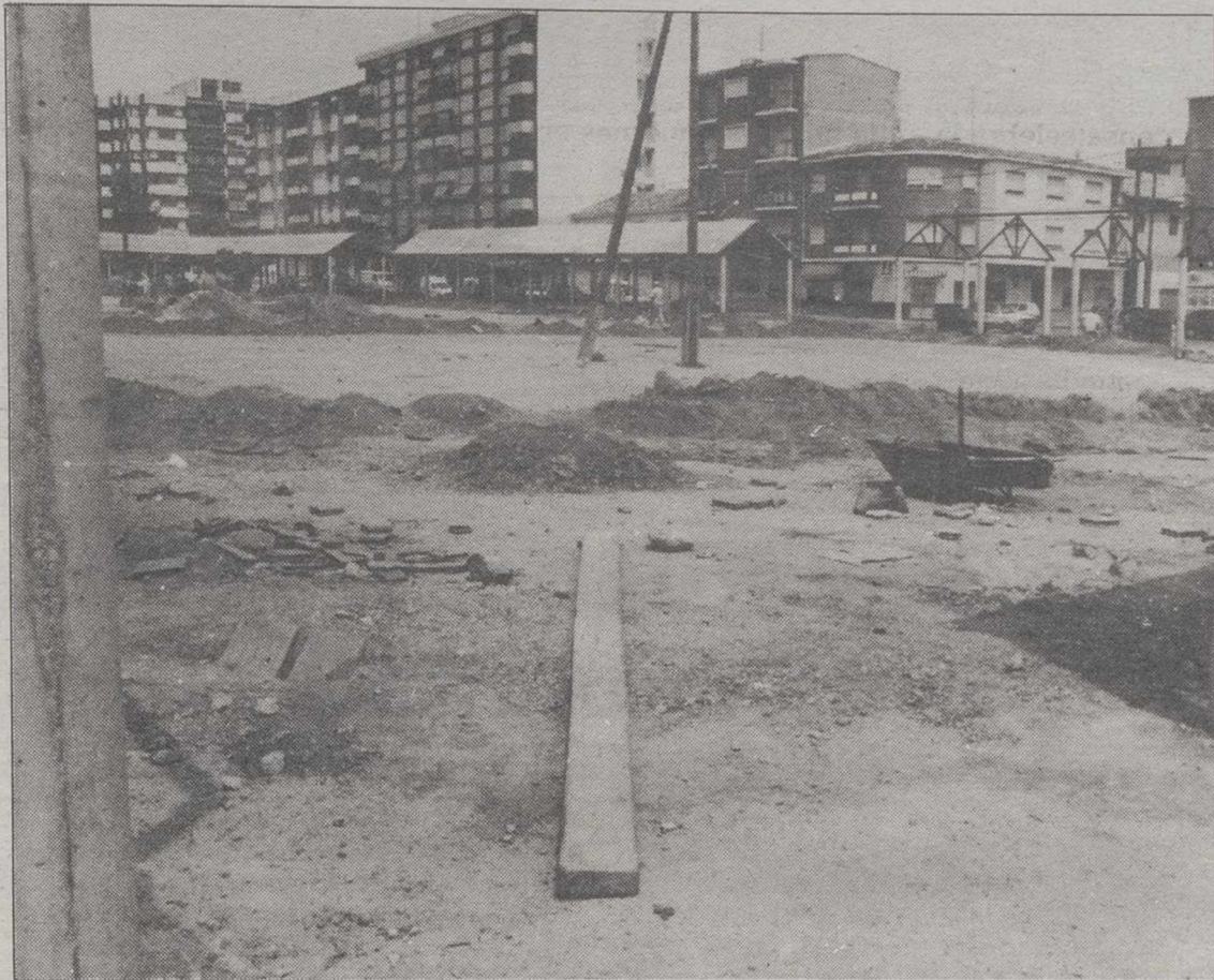
Obras de remodelación en el recinto ferial hellinero. JESUS MORENO
