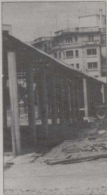
Obras en el recinto ferial
