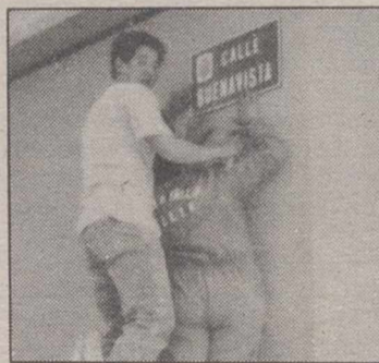
Instalación de los nuevos rótulos.
