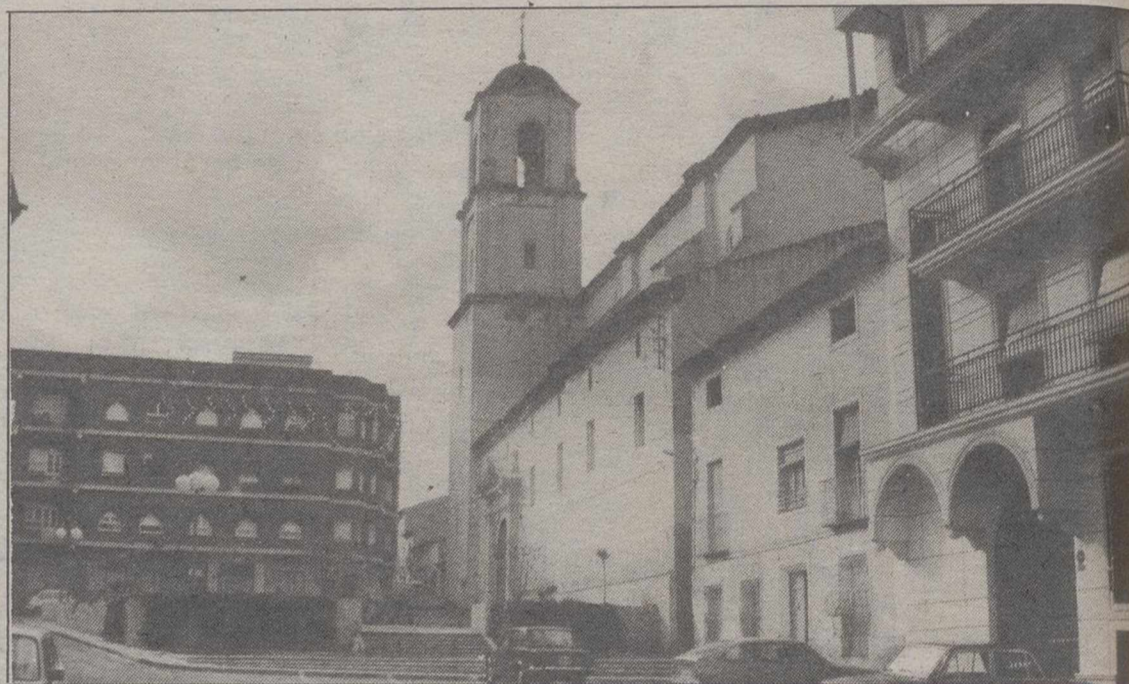
El término municipal de Tobarra se verá beneficiado de las nuevas obras adjudicadas por el MOPU
