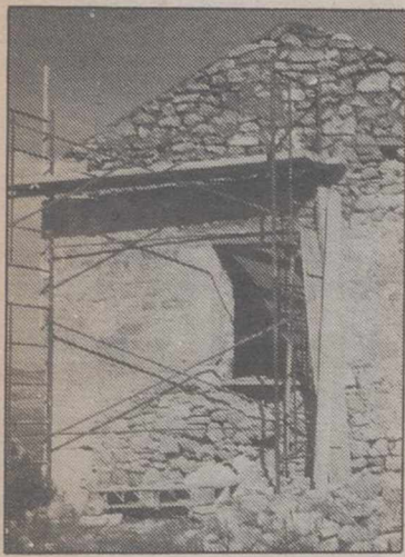
Obras de restauración de la ermita.
