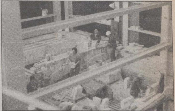
Construcción de cámaras regenerativas del horno de fusión de vidrio de la fábrica de Caudete.
