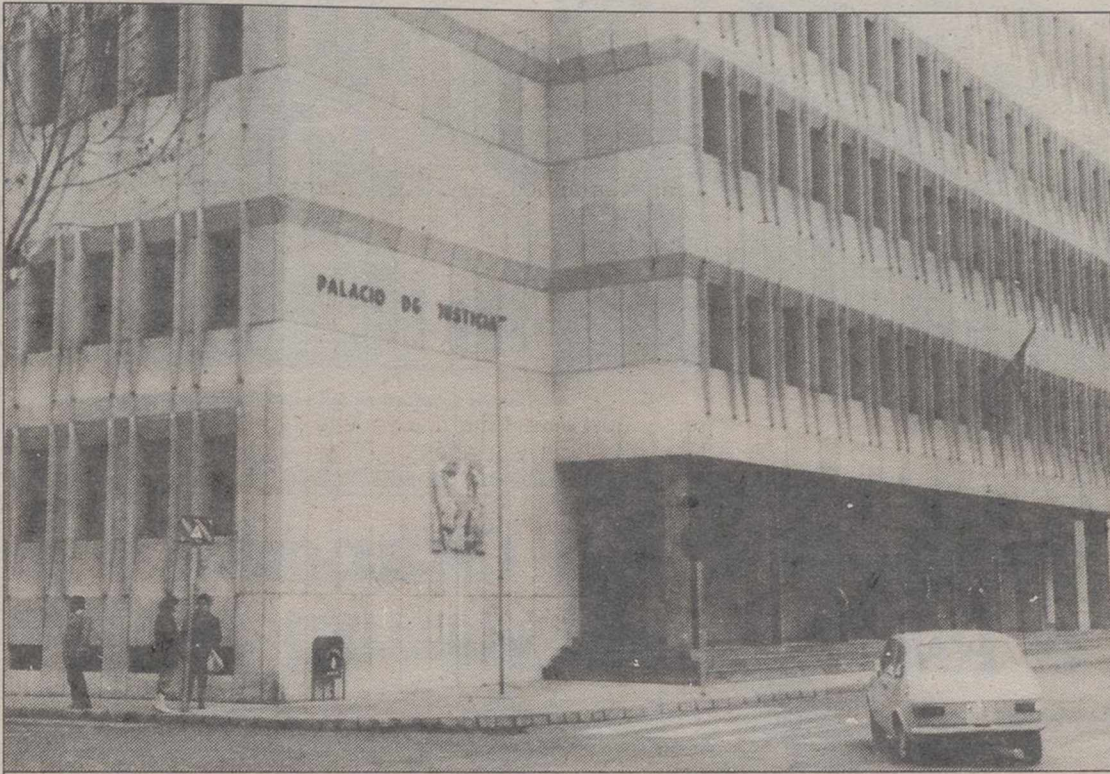
El Palacio cuenta con la infraestructura necesaria para acoger al Tribunal Superior
