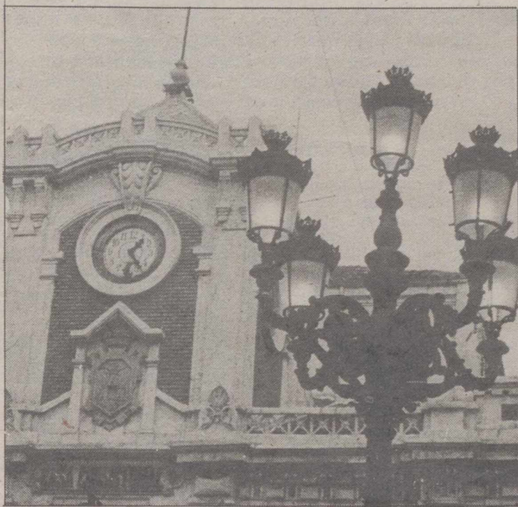
En primer lugar se actuará en el edificio del antiguo Ayuntamiento. LUIS MIGUEL
