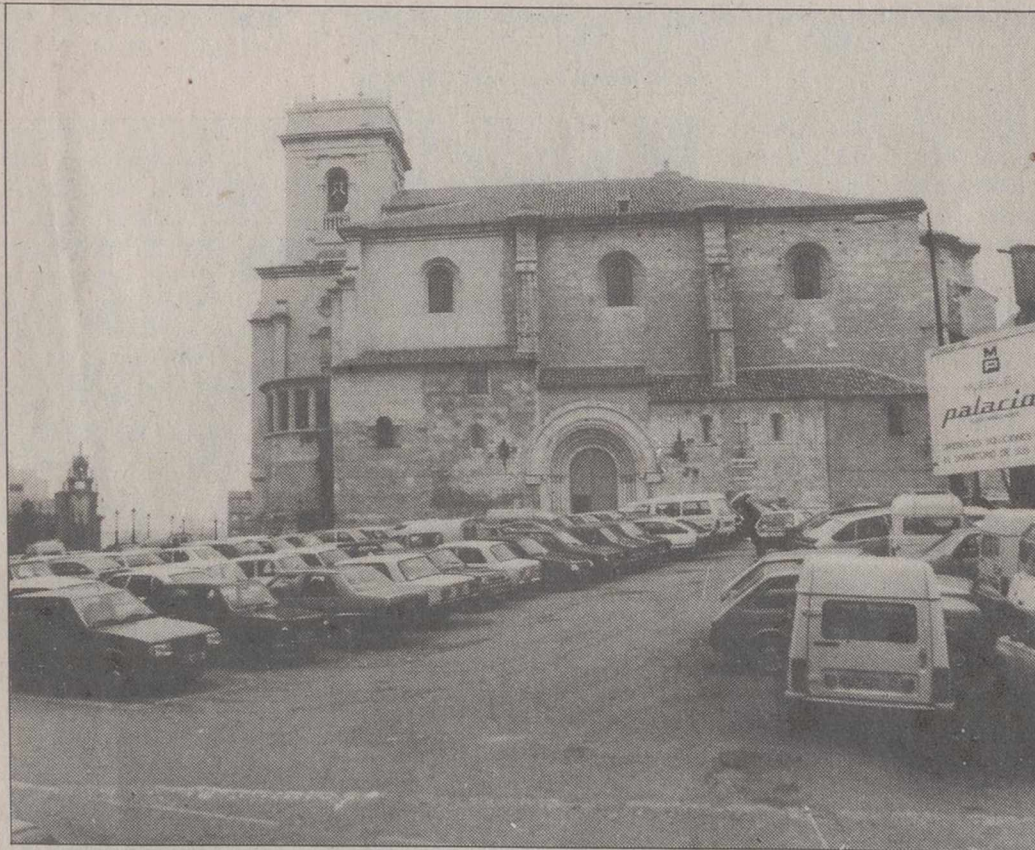
La actual explanada será el centro de la plaza y tendrá un aparcamiento subterráneo.
