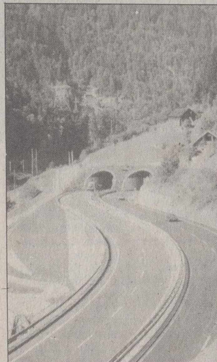
Entrada al túnel suizo de San Gotardo.
