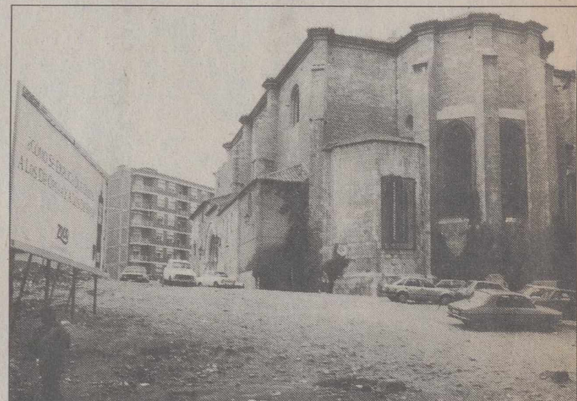
Está previsto que la calle del Rosario se ensanche y se acabe con la imagen actual.
