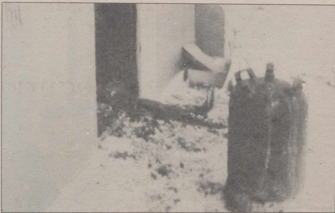
Estado en que quedó la vivienda incendiada
