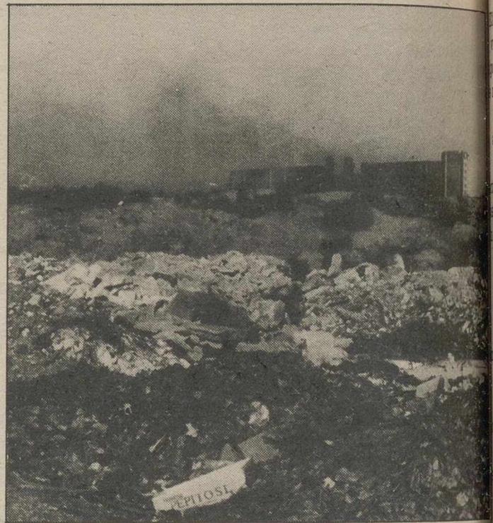
Las obras podrían comenzar a primeros de noviembre
