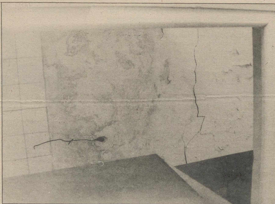
La inhabilitabilidad de los nuevos locales ha sido detectada por el Gabinete Técnico de Seguridad e Higiene de Trabajo.
